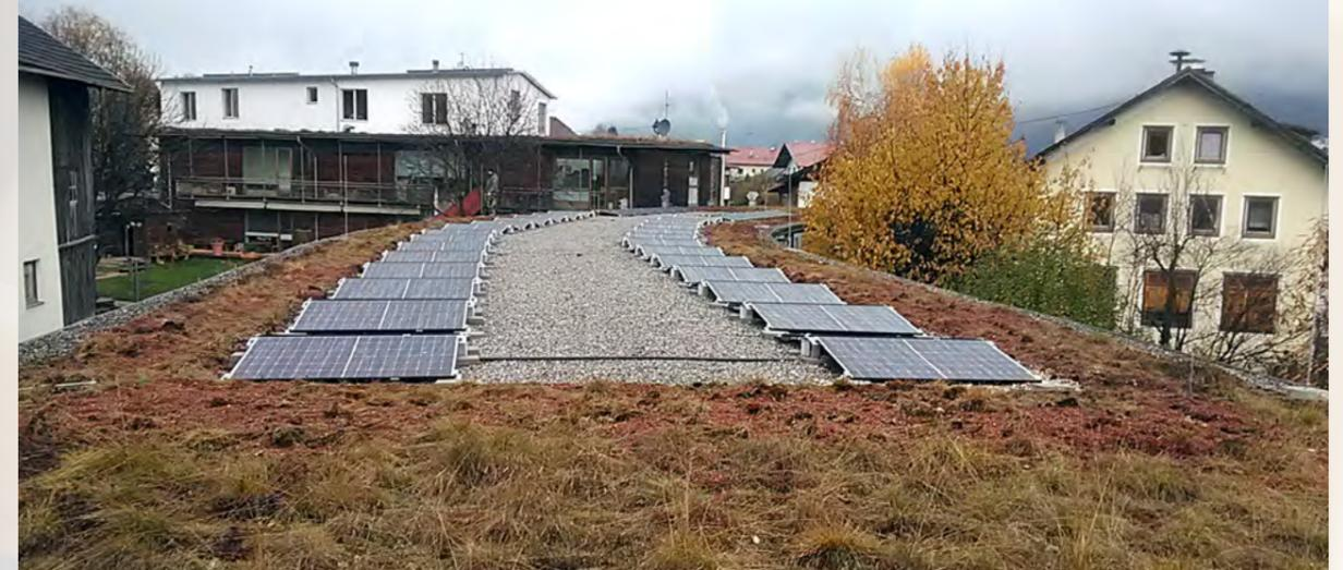
Noch im Herbst 2023 wurde auf dem Dach des Gemeindeamtes eine Photovoltaikanlage installiert und in Betrieb genommen. Die Anlage weist eine Nennpassleistung von 34 kWp auf. Die Kosten für die Anlage belaufen sich auf rund € 62.000,-. Dafür wurde eine Förderung in Höhe von ca. € 15.000,- in Aussicht gestellt.
